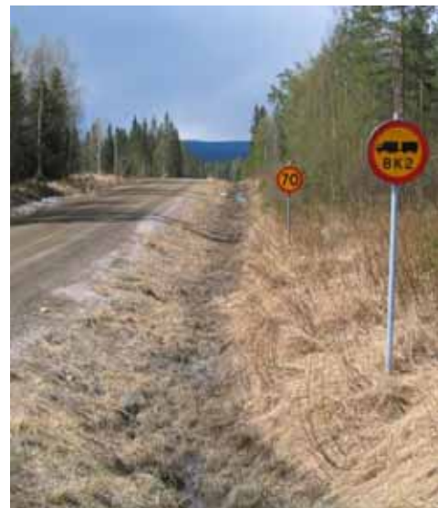
Figure 19. BK 2 road in Övertorneå Sweden.
