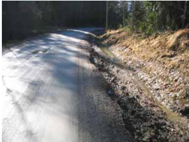
Kuva 3.5. Sortunut tien reuna silteisellä alueella. Kuva on otettu ensimmäisenä keväänä ojan kunnostuksen jälkeen.
