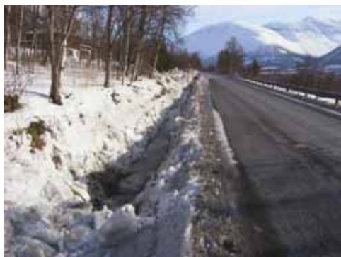
Kuva 3.3. Ojasta poistetaan jää ja lumi.
