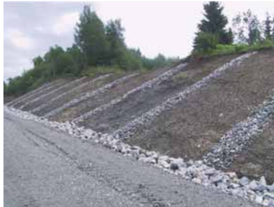
Kuva 3.10. Esimerkki leikkauksen puoleisen luiskan pysyvyyden parantamisesta.
