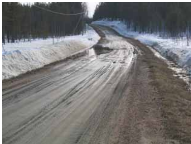
Figur 3.7. Dräneringsproblem på lågt liggande mark, Rd 19778, Kemijärvi, Finland.
