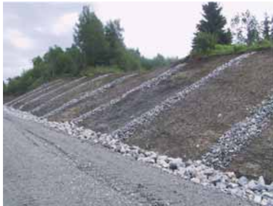
Figur 3.9. Ett exempel på hur en skärningsslänt kan göras mer stabil.
