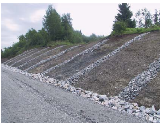
Assiliaq 3.10. Assersuut aqqusernup sinaani uinganeq aal akkaatsunngortinniarlugu.
