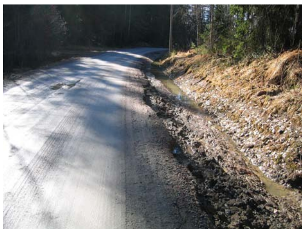
Assiliaq 3.5. Aqquserngup sinaa nakkaattoornikoq silteqarfiusumi. Asseq assilisaavoq aattulerfiup siulliup nalaani saligisoqarnerata kingunerani.
