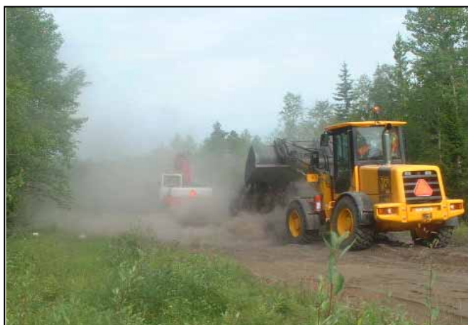
Kuva 6: Tielle BD694 levitetään metsäteollisuuden lentotuhkaa, Vitåfors, Ruotsi. Kuva T. Nilsson 2002
