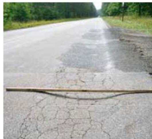
Рисунок 2.3. Колейность нижних слоев дорожной одежды вызывает разрушение асфальтобетонных слоев
