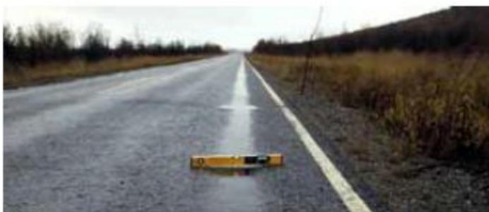
Рисунок 2.2. Застой воды в колее на покрытии из черного щебня
