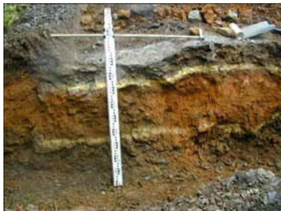
Рисунок 2.9. Покрытие дороги, показанной на Рис. 2.7 и 2.8, в поперечном сечении. (Границы слоев обозначены краской-спреем) (фото: В. Тиррелл)
