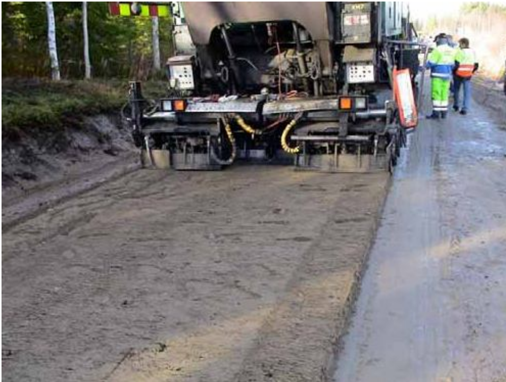
Рисунок 1.2. Обработка материалов слоя износа/основания стабилизирующей добавкой
