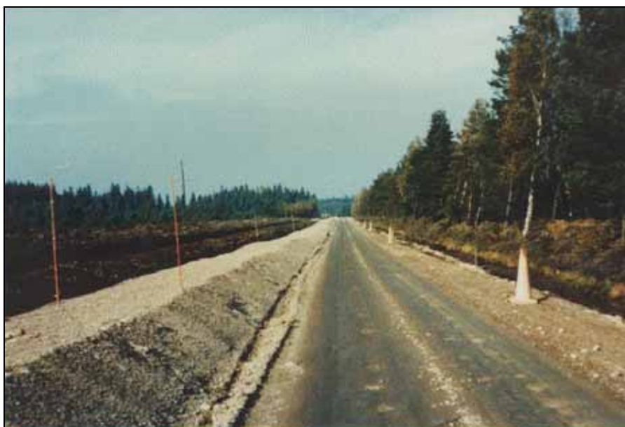
Figur 6.11 Fotografi från en breddning av en flytande väg över torv med förbelastning.
