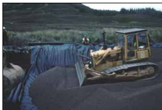
Figur 6.9 Projekt med lättviktsrehabilitering i Skottland
