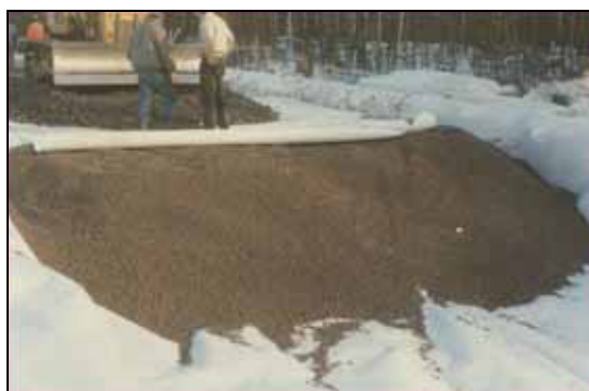
Figur 6.8 Projekt med lättviktsrehabilitering i Finland
