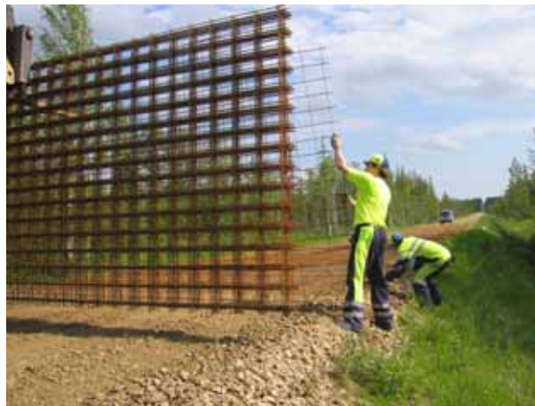
Figur 5.1. Indbygning af jernarmeringsnet. (K. Niva)
