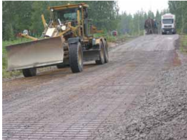
Figur 5.3. Groft knust materiale bør anvendes under jernarmeringsnettet for at sikre sammenlåsning. (T.Ruohomäki)
