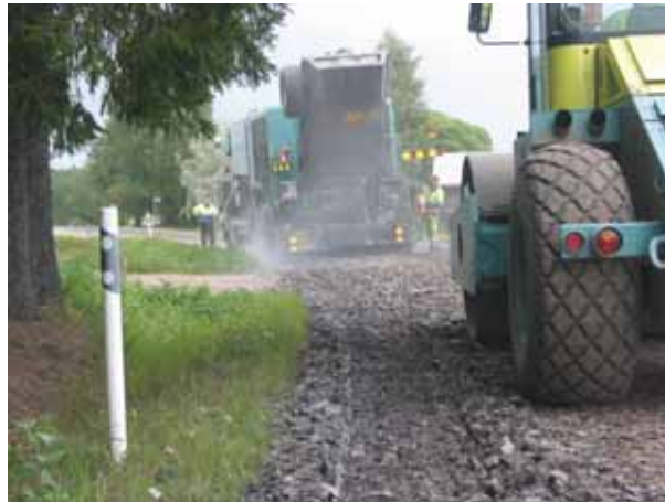
Figur 5.4. Den eksisterende overfladebehandling fræses først ned i bærelaget. (T.Ruohomäki)
