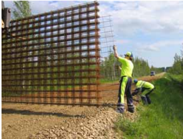
Kuva 5.1. Teräsverkon asentamista. (K. Niva)
