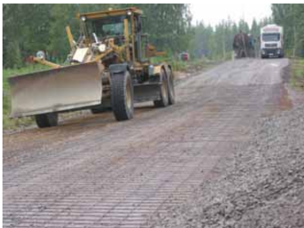
Kuva 5.3. Karkearakeista materiaalia tulisi levittää teräsverkon alle takaamaan verkon lukkiutumisen paikalleen. (T.Ruohomäki)
