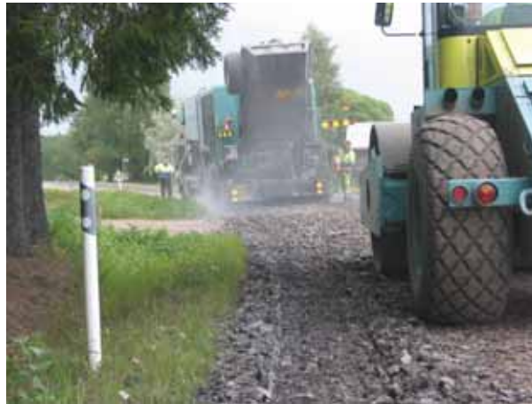
Kuva 5.4. Vanha päällyste sekoitetaan ensin kantavaan kerrokseen. (T.Ruohomäki)
