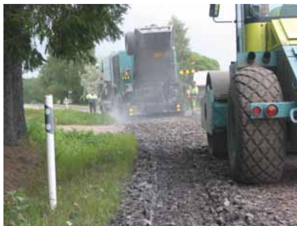
Figur 5.4. Befintlig ytbehandling fräses först in i bärlagret (T. Tuohomäki)
