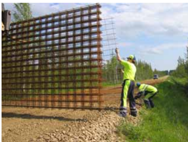
Figur 5.1. Installation av stål nät sarmering (K. Niva).
