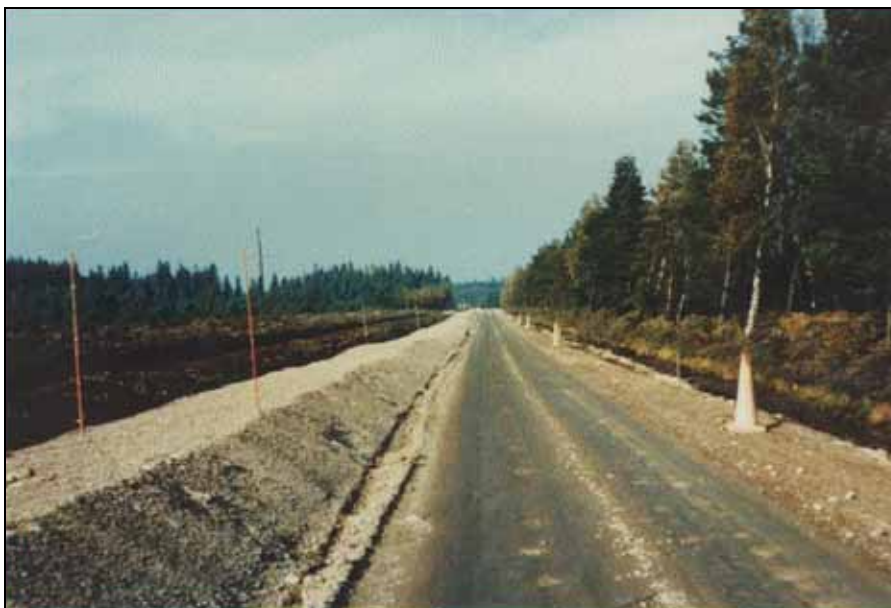
Kuva 6.11 Valokuva turpeen päällä kelluvan tien leventämisestä esikuormituksen avulla.
