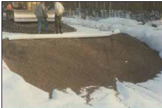
Kuva 6.8 Kunnostus kevyellä materiaalilla Suomessa
