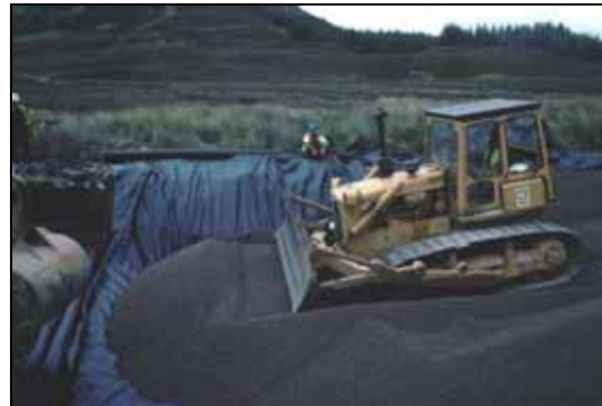
Kuva 6.9 Kunnostus kevyellä materiaalilla Skotlannissa
